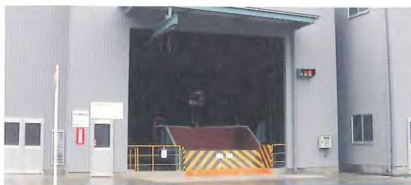
廃プラスチック破碎処理設備
