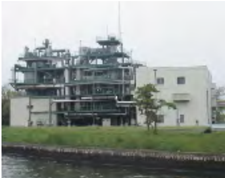
仙塩浄化センター焼却炉
