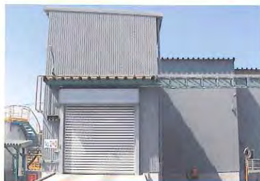
下水汚泥処理設備
