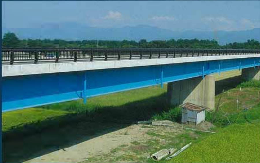
床板架替工(高強度軽量プレキャストPC床板), 大川橋 秋田県 施工: ビーシー橋梁JV
