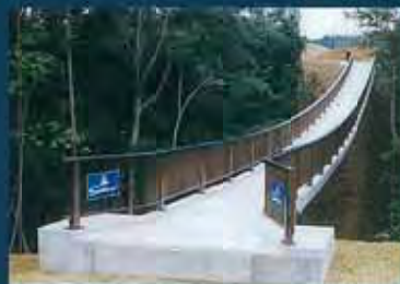
サザンヤードカントリークラブ 設計: 鹿島建設 施工: 鹿島建設 (新素材アラミド繊維使用の軽量コンクリート)
