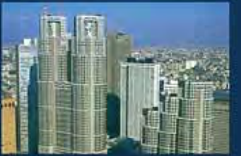
東京都庁舎 設計: ムトーアソシエイツ・丹下健三・都市・建築設計事務所 施工: 第1庁舎、大成建設・竹中工務店・清水建設 施工: 第2庁舎、鹿島建設・大林組・住友建設
