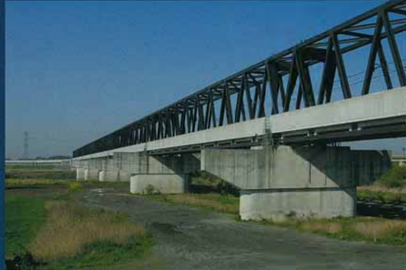
つくばエクスプレス・利根川橋梁(日本鉄道建設公団) 施工: IHI・NKK・松尾 JV 他
