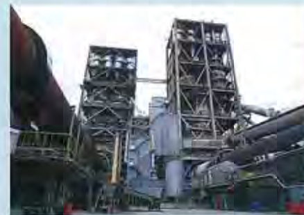
サスペンションプレヒータ(奥)とロータリキルン New suspension preheater and rotary kiln
