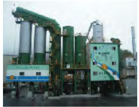
アスファルト混合物製造工場
