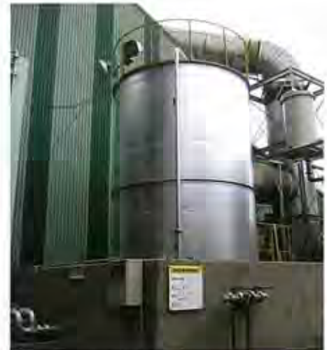
廃飲料水タンク
