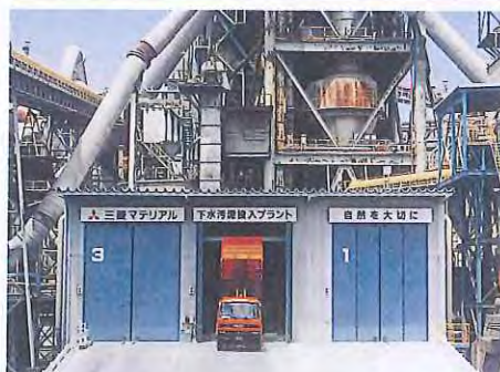
汚泥処理設備
