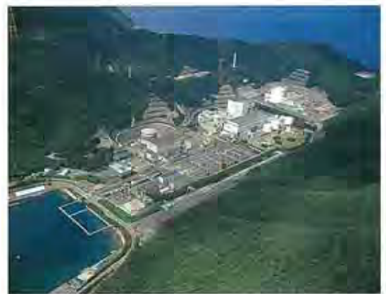
敦賀原子力発電所
