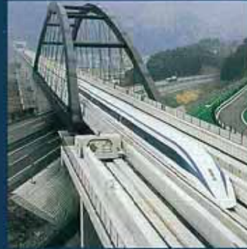
山梨リニア実験線小形山架道橋 設計: 日本鉄道建設公団 施工: 横河ブリッジ
