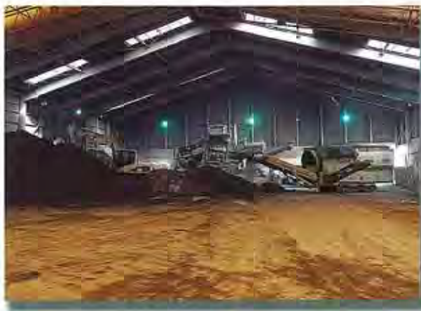
建設発生土改質ヤード
