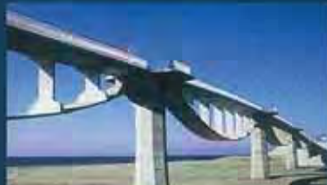
浜松御前崎自転車道 潮騒橋 施工: 住友建設
