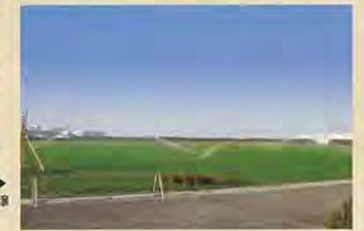
下水処理場覆蓋緑化工事 ▶ 芝生の下に植栽土壌には、現地発生土とメサライト土壌改良材として粗目砂の混合土壌が使用されています。
