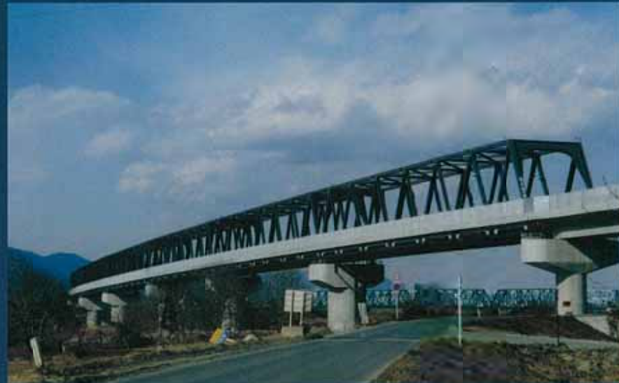
北陸新幹線・第三千曲川橋梁(日本鉄道建設公団) 施工: 横河ブリッジJV
