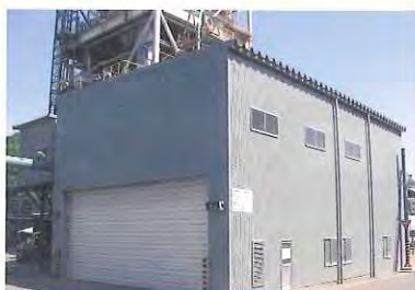
有機系廃棄物処理設備
